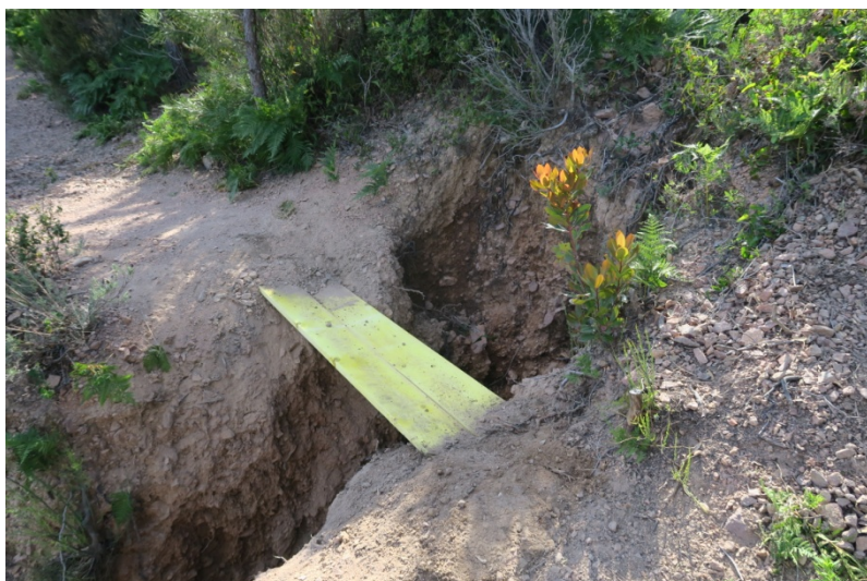
Première passerelle provisoire
